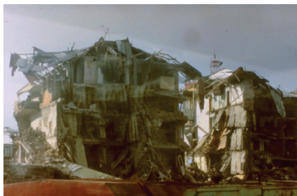
Рис. 116. Квартал многоэтажных домов, разрушенных Спитакским землетрясением. Автор: С. J. Langer. U. S. Geological Survey
