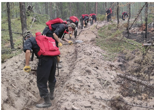
Рис. 120. Военнослужащие ВВО вручную прокладывают в лесу минерализованную полосу для предотвращения распространения огня.
