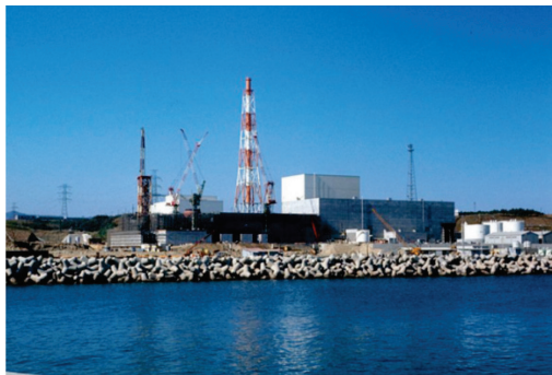
Рис. 123. Строительство защитной дамбы АЭС «Фукусима-1», 1970 г. Источник: United States Department of Energy
